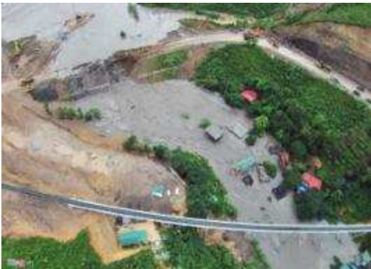
Hình 1. Bùn đất đá thải than công ty than Mông Dương tràn qua đập trôi xuống khu dân cư ở phường Mông Dương (Cẩm Phả) trong đợt mưa lớn năm 2015 (Hoàng Anh & nnk., 2015).
